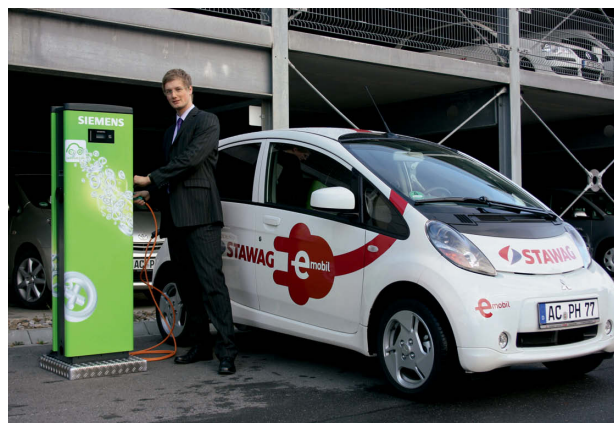
Siemens erweitert ladenetz.de-Systembaukasten: Ein E-Auto der STAWAG, Stadtwerke Aachen AG, wird an einer Siemens-Ladesäule, die an ladenetz.de angeschlossen ist, mit Strom versorgt. Quelle: smartlab
