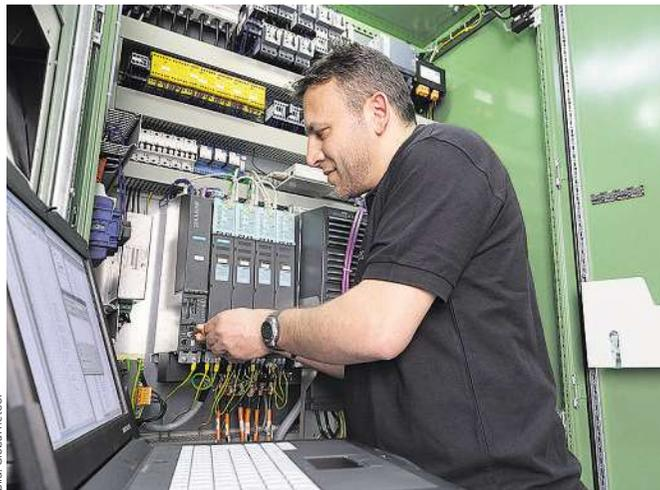
Zur Modernisierung einer Maschine gehört auch der Umbau des Schaltschranks.
