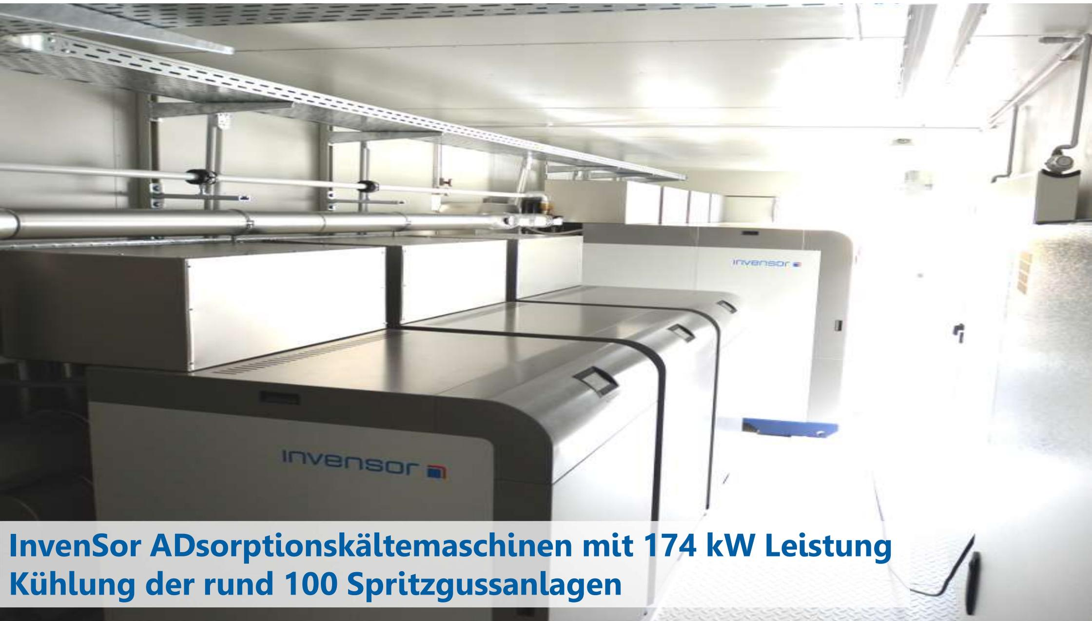
**InvenSor ADSorptionskältemaschinen mit 174 kW Leistung
