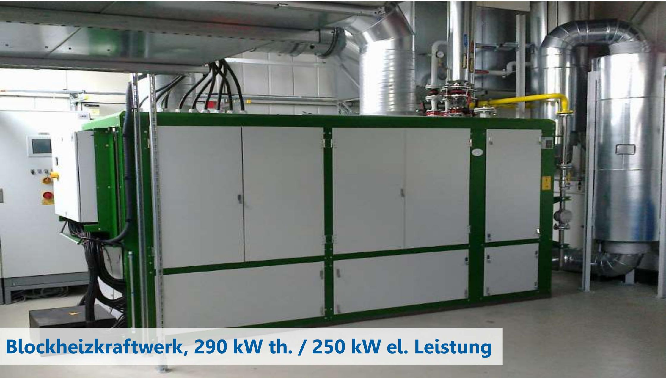
**Blockheizkraftwerk, 290 kW th. / 250 kW el. Leistung**
