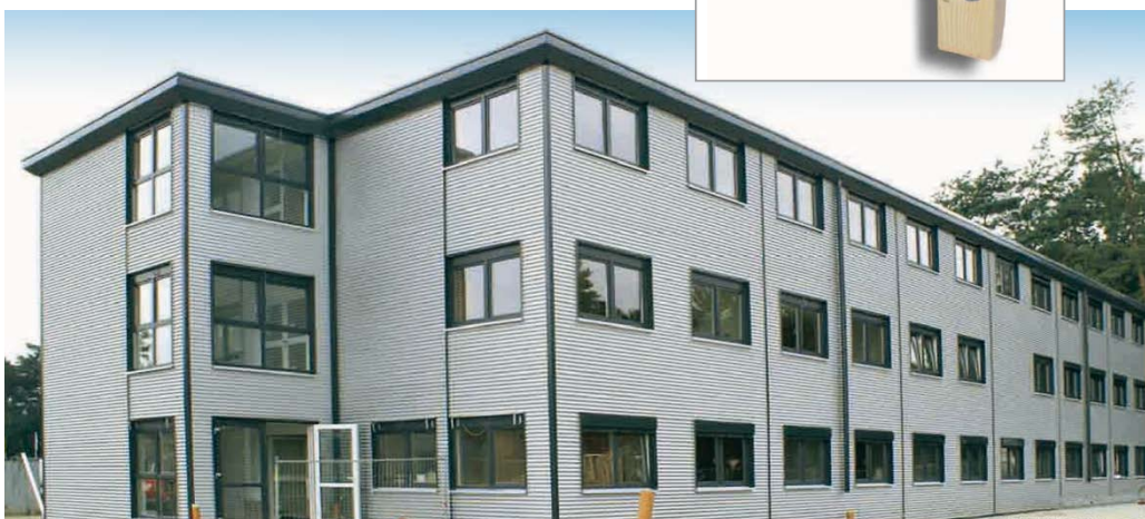
Modulraumbau Karl Hoffmeister GmbH arbeitet mit frei wählbaren Systemgrößen.
